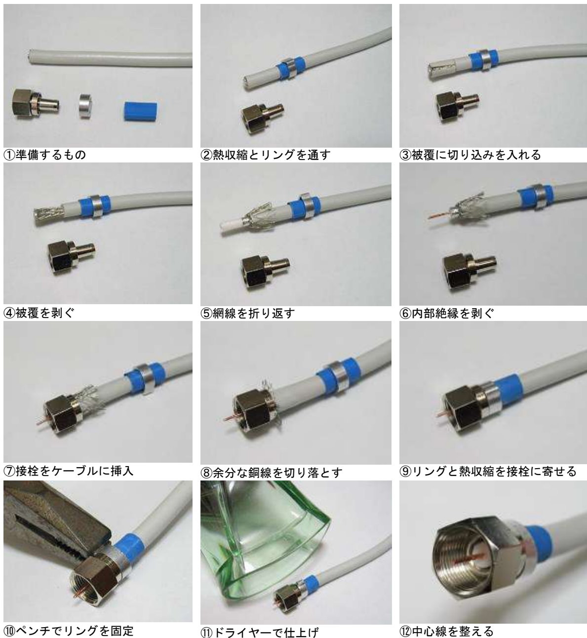
写真 4-7 F型接栓の加工手順
